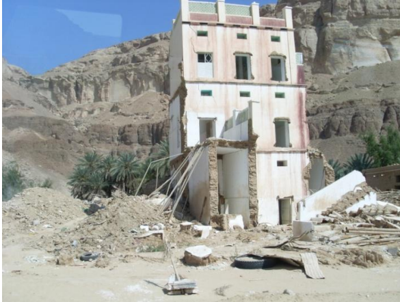
صورة ( 8 ) مرور مياه السيل إلى الدور الأول وتهدم جزئي للمبنى
