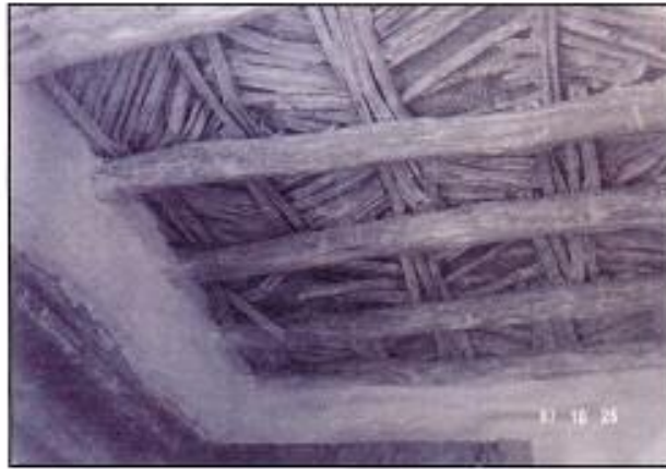
صورة رقم (٧) تفاصيل تكوين الأرضيات والسقوف
