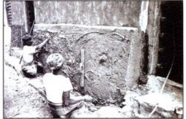
صورة رقم (٢) ترميم الجدران السفلية
