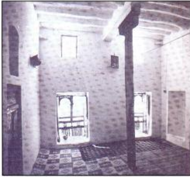
صورة رقم (٦) العمود ذو الذروة خشبية (الكبش)
