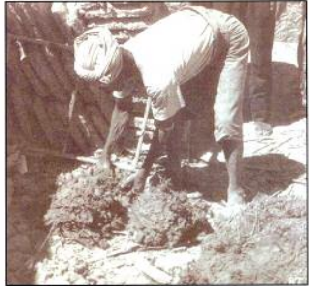
صورة رقم (4) تقليب خليط الطين والتين الماء
