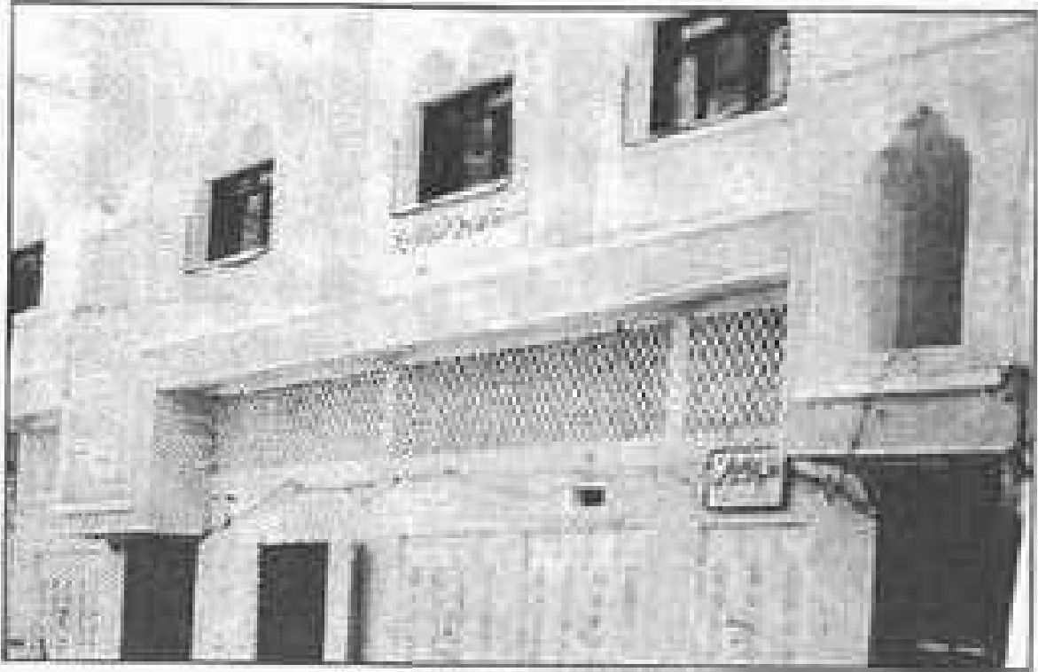
مدرسة الطاروق بعد بناء الطابق الأول
