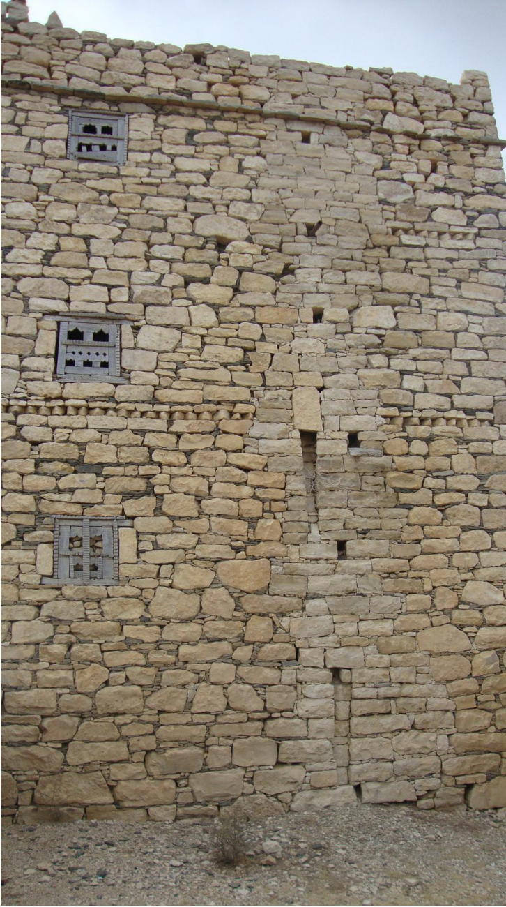
شكل 45: صورة للواجهة الجنوبية للمبنى الرئيس لحصن غمزان.
