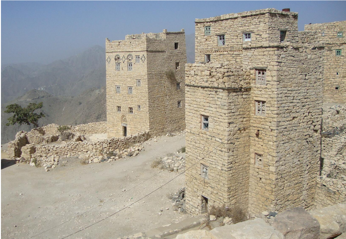
شكل 31: صورة للواجهة الشرقية لحصن عُشّام.
