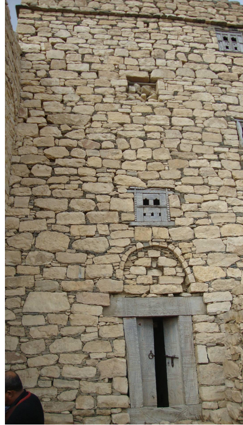
شكل 41: صورة للواجهة الجنوبية للمبنى الرئيس لحصن غمزان.
